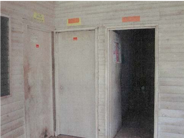
写真15 エイドポストには分娩室・陣痛室があるが（中央の扉）、この地域は自宅分娩が多いため、分娩室・陣痛室は長い間使われていない。
