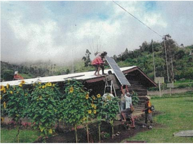
写真13 ヘルスセンターの屋根へのソーラーパネル設置作業。専門業者の指導の下、住民も積極的に作業をサポートしていることが窺える。
