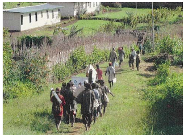
写真12 モロベ州レイから軽飛行機で1時間のところにある山村のヘルスセンターにて、ソーラー式冷蔵庫の設置工事を視察。住民が冷蔵庫の搬送を手伝っている。
