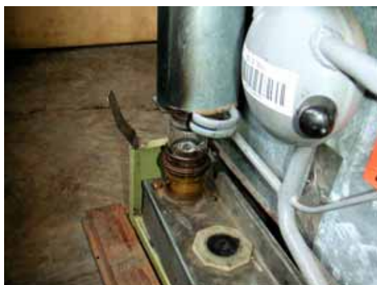
写真12 メンダガン基礎保健施設にある灯油電気両用型冷蔵庫の裏側で、この地域は電化されていないため灯油で冷蔵庫を稼働している。
