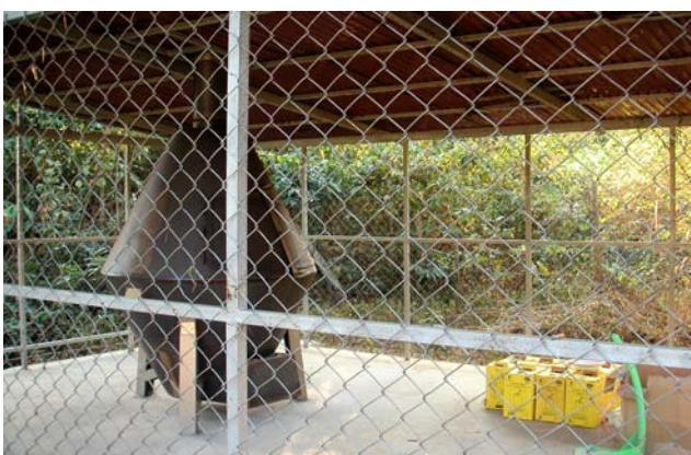
注射針の焼却炉 2004年、WHOは「ラ」国全県に対して、焼却炉を配布した。焼却炉は県保健局が管理し、各医療施設はセーフティボックスを持参し、ある程度貯まったら燃焼廃棄する。人が近づけないように柵に囲われている。
