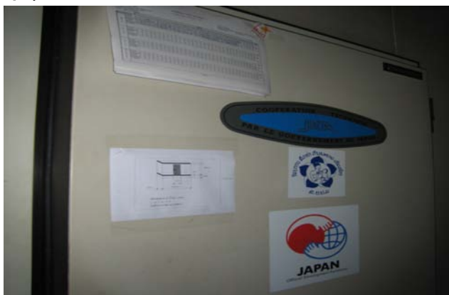
EPI中央倉庫の冷蔵室 EPI中央倉庫では、「ラ」国内で配布するワクチンを保管している。冷蔵庫の温度管理やメンテナンスの注意事項が冷蔵庫表面に貼られている。
