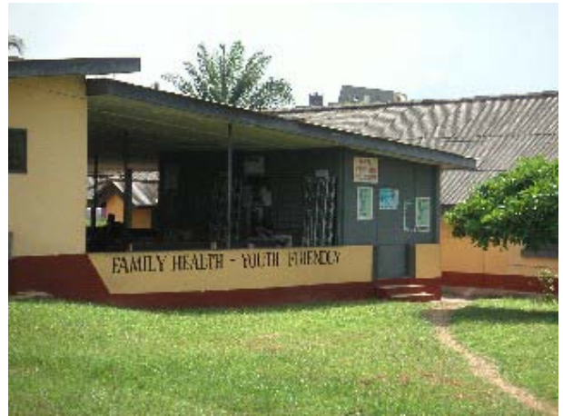
写真2 母子保健センター外観。妊婦健診サービスの提供や、伝統的産婆を巻き込んだクリーン・デリバリー推進を行っている。
