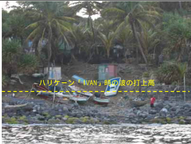
写真(1)-6 既存水揚地
