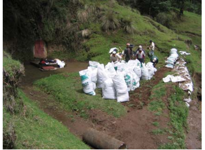
モリノビエホ湧水源 N-9:土のう作業中。
