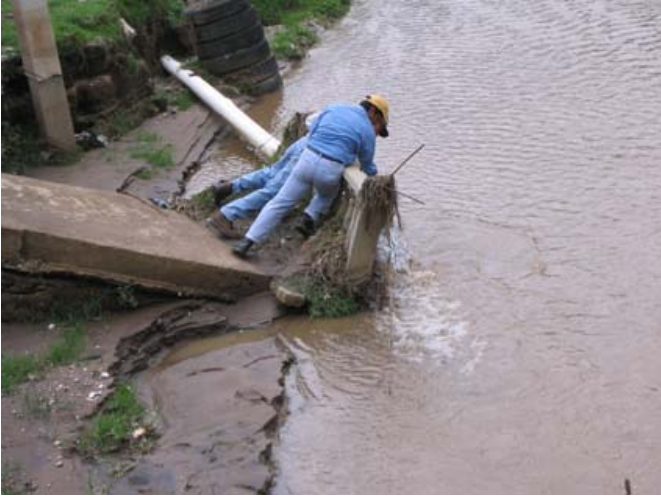
モリノビエホ湧水 N-8 & 9 導水管:地盤とともに管路が流出。断絶している。
