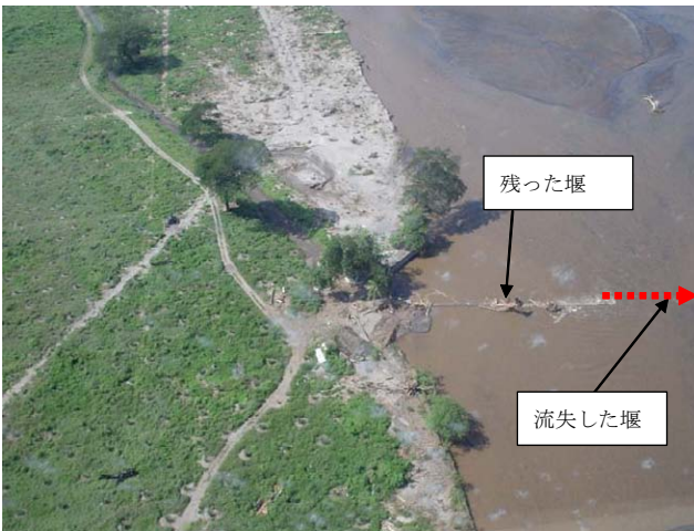
ラ・ブランカ左岸側の一部を残し半分以上の堰が流失している。
