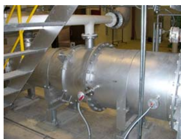
↑ レキュペレータ入り口排ガス温度計
