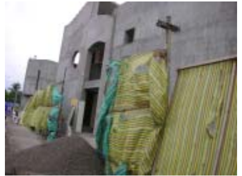
ガラパゴスは人口が急増しており、 建設ラッシュ
