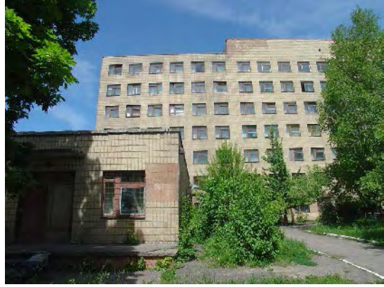
外来棟(1976年建設)
