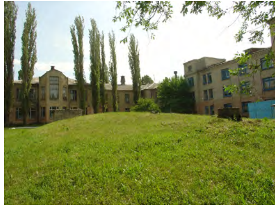
小児外科棟 (1976 年建設)
