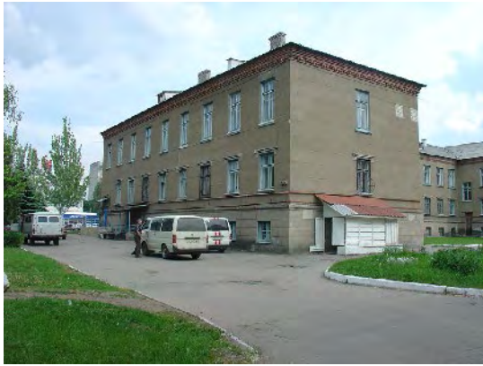
外来棟 (1972 年建設)
