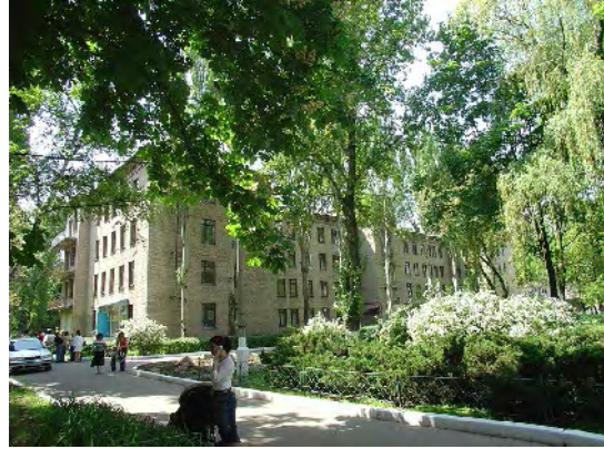
小児外科棟（1965年建設）
