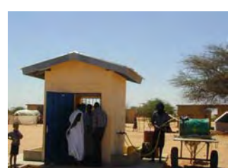
24：公共水栓における住民による維持運営
