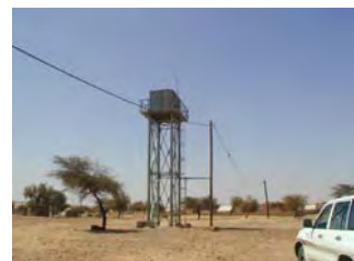
9 : Belemtar 高架水槽
