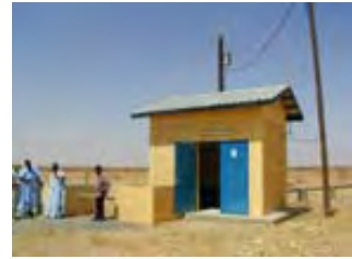
3 : 揚水ポンプ場 JF-2 2 箇所の井戸
