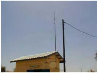
1 : 揚水ポンプ場
