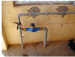
11 : 公共水栓 内部 バルブ修理後、外壁補修
