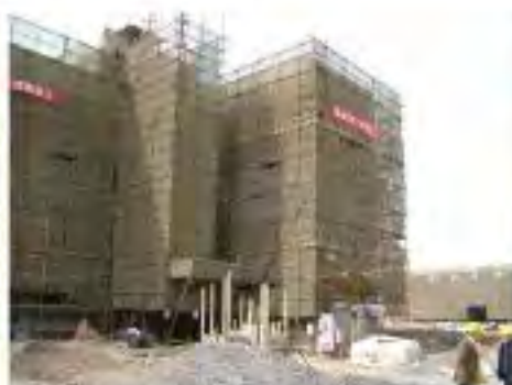
中継輸送基地建設現場(基地用建屋)
