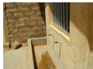
12 : 公共水栓 外部 水栓撤去後
