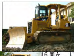
15. 同上 湿地ブルドーザー 1台
