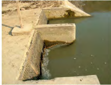
5. 同左 取水口 スクリーン (再塗装) 滞留浮遊物は状況に応じ除去されている
