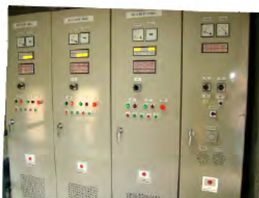
14. 同上 更新された操作パネル類、左よりポンパネルNo1、同左No2、同左No3及び230V受電版
