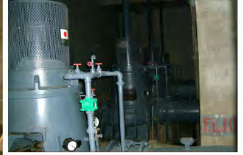
10. 同左 モーター部 (3基)、オーバーホール済み、 発動機部分はワイヤー部まき直し点検済み)
