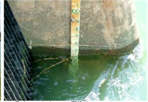
3. 取水口スクリーン、再塗装。 (水位ゲージ目盛り 0.4m)
