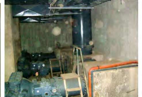
6. 同左 主ポンプ3基。検査後漏水部等修復済み
