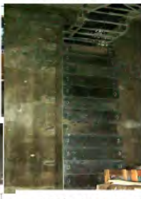
17. 配線ダクト及び ラック、更新
