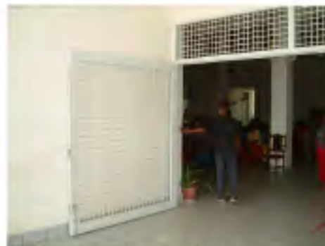
5.外来エントランス格子扉
