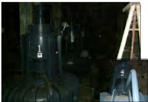
11. 主ポンプ(4基) オーバーホール
