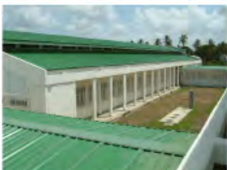
24.病棟外観と浄化槽
