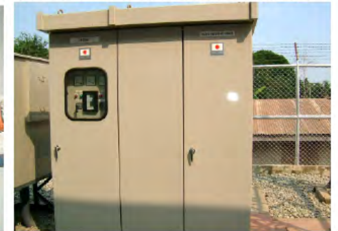
9. 同左 受変電設備。点検整備後、再塗装
