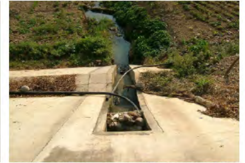
6. 同左 護岸工事 排水溝 護岸上部よりの遠景
