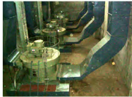
12. モーター(4基)オーバーホール、一部駆動部更新 及び、ダクト再塗装
