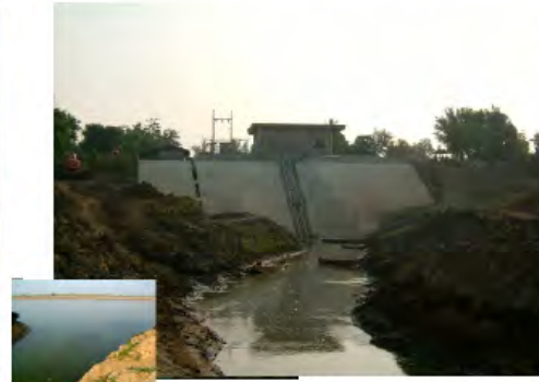
2. 同左 遠景(護岸工事部分)、左下は水源河川
