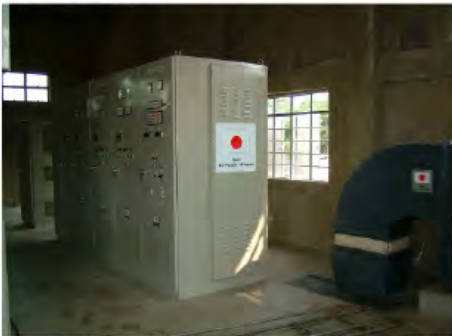
4. 同上 補修・更新後の操作盤、右、再塗装済みダクト
