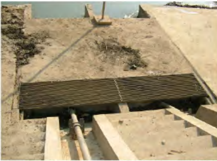
4. 同上 取水口傾斜ゲート (2基)更新、及び階段工
