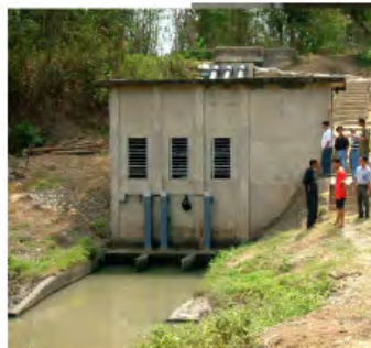
11. 同左 取水ゲート側よりの遠景
