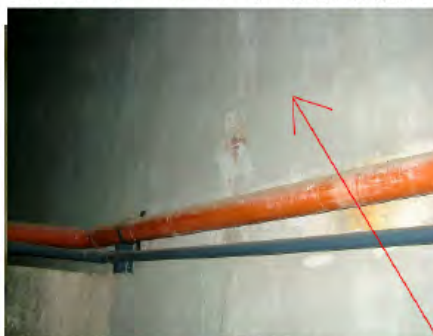
8. 同左 壁。漏水部修復後再塗装済み
