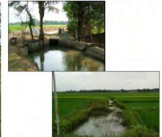
17. 同左 上より幹線水路(コンクリート製)主排水路(土)水利組合(IA)代表
