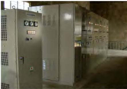
8. 同上 更新された盤類 左から直流電源装置、 460V受電盤、ポンプ操作パネル 3台、補助機盤
