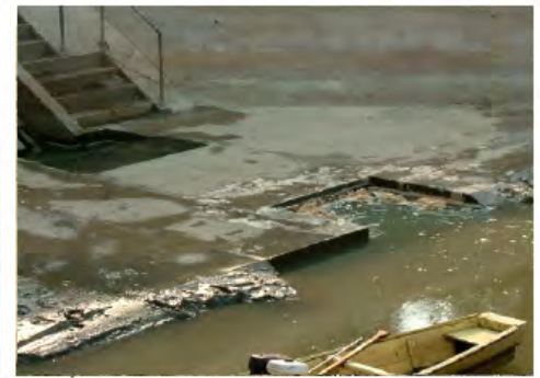
3. 同左 取水ゲート部(傾斜型)
