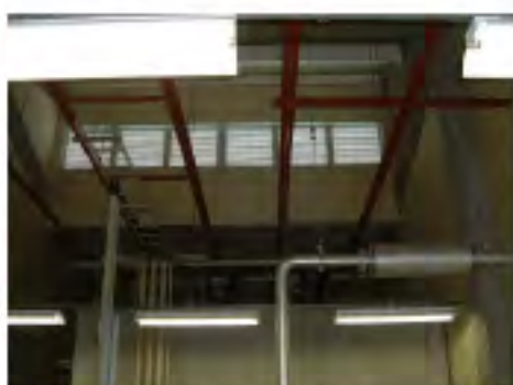
21.電気・発電器室上部
