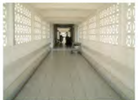
9.病棟間渡り廊下
