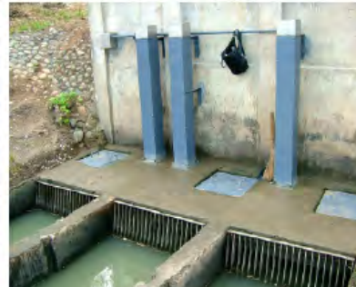
12. 同左 既存取水ゲート及び金属部分再塗装済み
