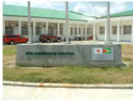
2.旗竿土台と銘板
