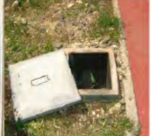
7. 埋設配管 更新
