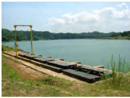
2. 取水口遠景(4カ所合計8門、内2ヶ所のストップログ更新及び、釣り上げジグ新設)
