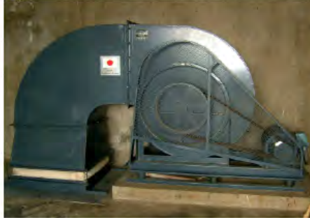
9. 換気ダクト、更新済み
