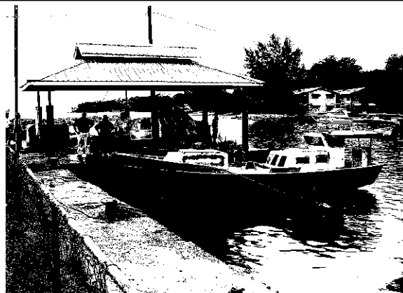
写真-15：物揚場（氷積込み状況）。ビクトリア漁港で購入した氷を陸送し、積込んでいる。
