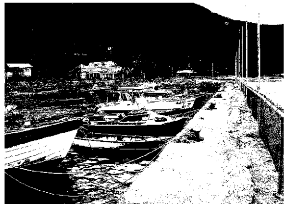
写真-14：休憩岸壁の係留状況。
