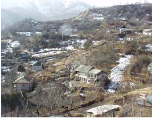
図 9.5 ゴッシュ村地すべり H ブロック全景写真
