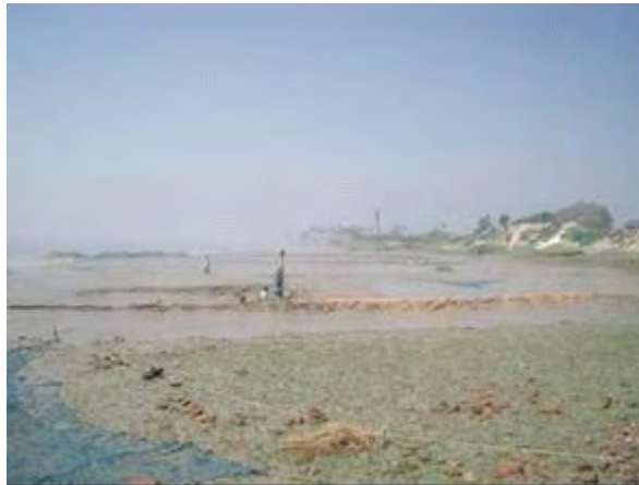
図 3-6 河床の状況(ライチャック側)
