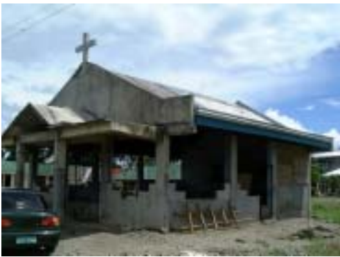
移転地に建設中の教会、その奥は学校
