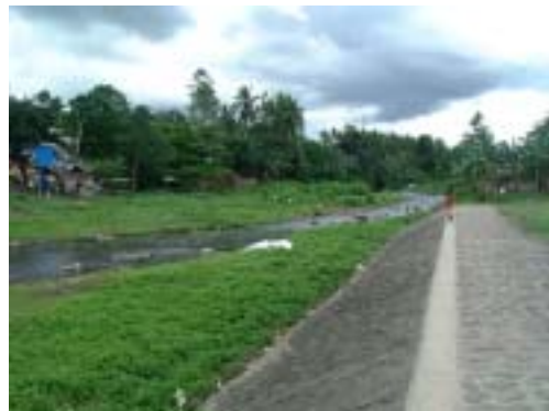
オルモック市街地上流部の河道改良と護岸
