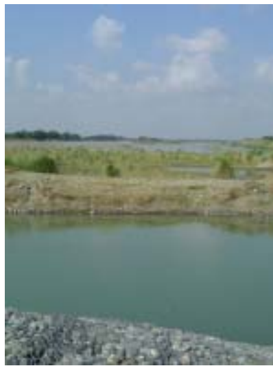
右岸に流路変更のため、右岸側水路を開削
