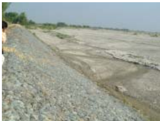
決壊危険箇所の緊急修復後
