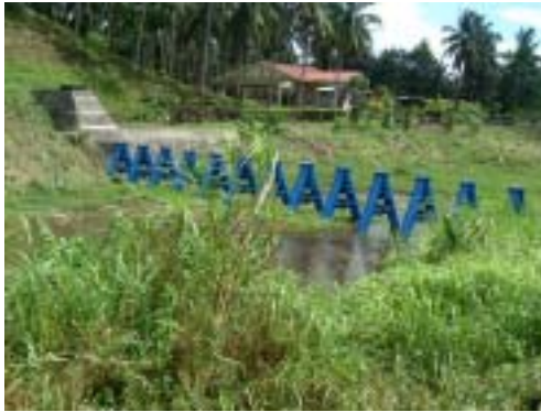
オルモック中上流部スリット・ダム
