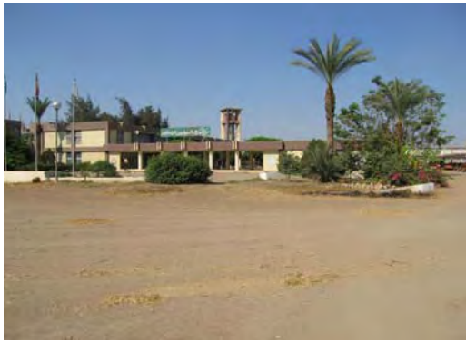
管理・研修棟の全景
