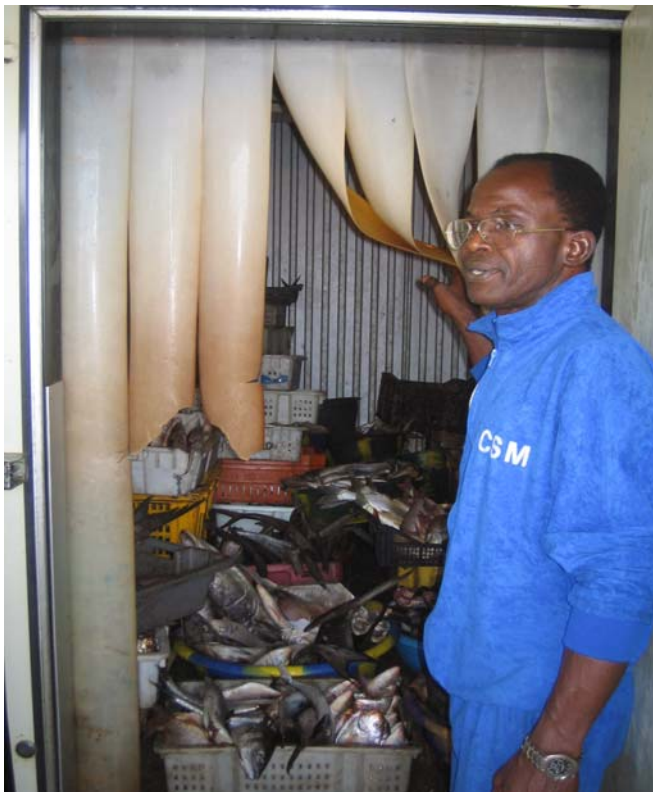
11. 既存冷蔵庫 午後は翌日用の魚で満庫状態の冷蔵庫。 魚箱単位で保管しており、入出庫も頻繁にある。
