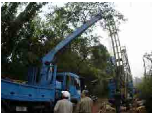
井戸掘削機による掘削状況1（北部 Ha Tay省）
