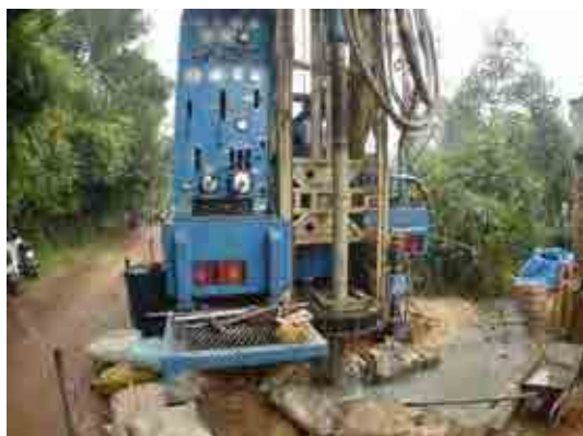
井戸掘削機による掘削状況2（北部 Ha Tay省）
