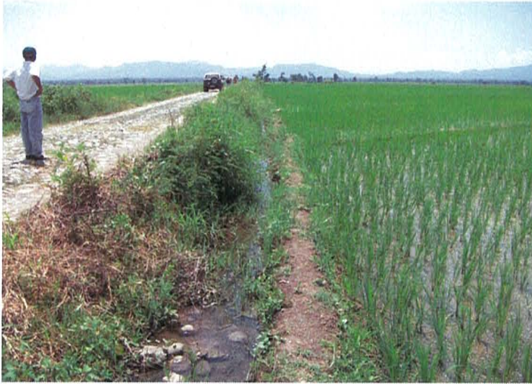
リタバウ 2次水路：STA. 3+900
