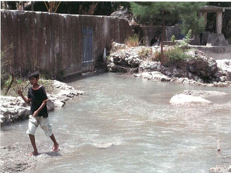
導流部および取水口スクリーン：
