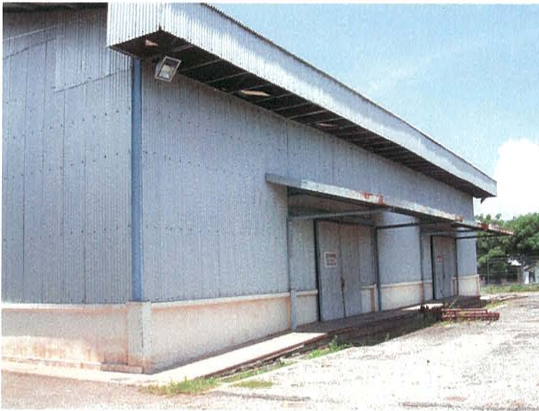
MAFF ボボナロ県農業事務所敷地内の貯蔵倉庫（背面）
