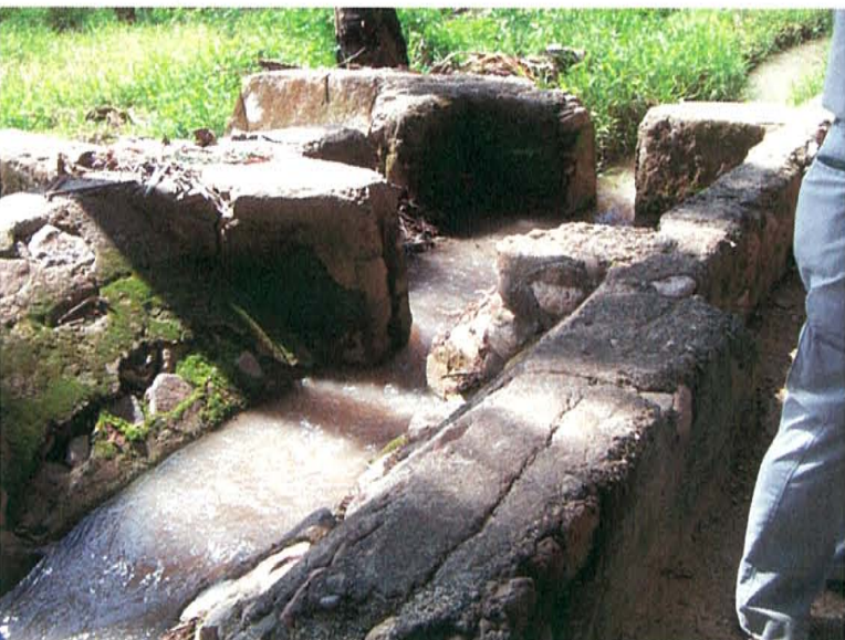
リタバウ 2次水路：STA. 4+770
