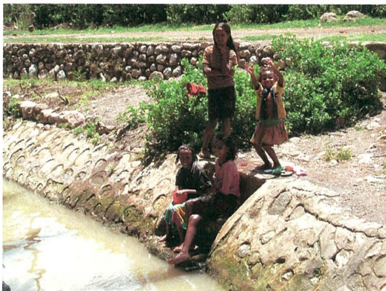
ラマスコラ 2 次水路：STA. 0 + 050 付近
