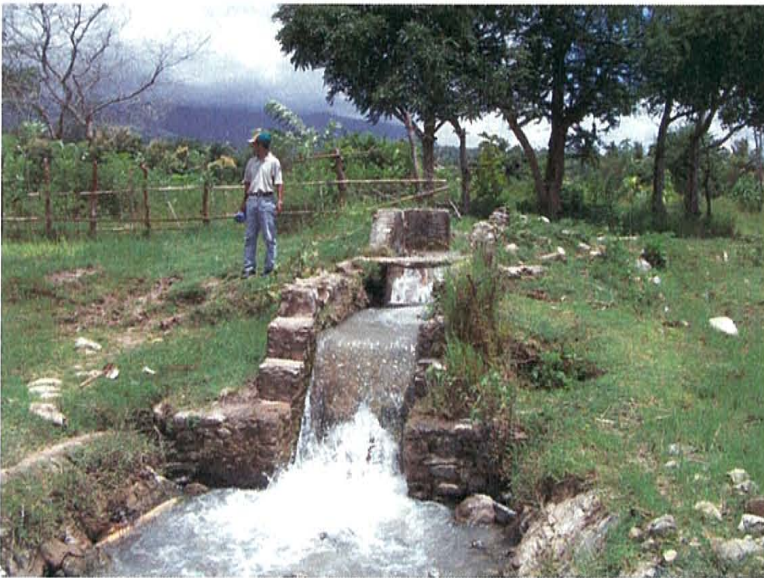
リタバウ 2次水路：STA. 0+210
