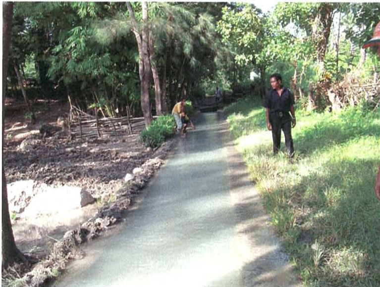
幹線水路：STA. 0+660 フルーム水路
