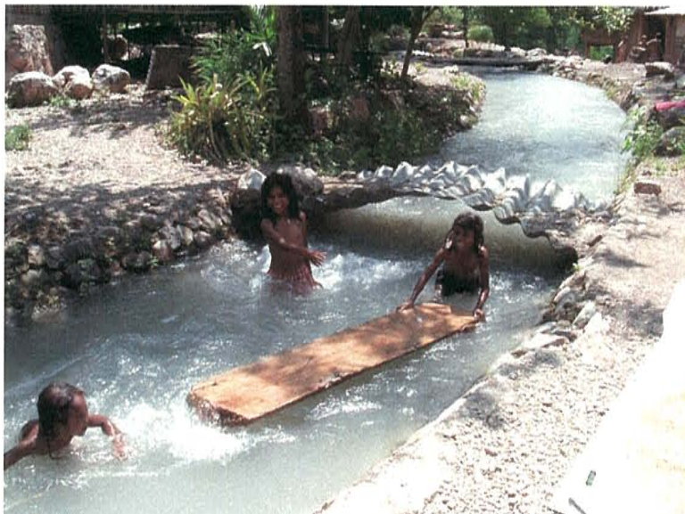
幹線水路：STA. 0+900 付近
