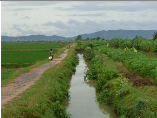
写真3：ハイズン省ナムザック県（ポンプ灌漑） 二次水路（素堀り）
