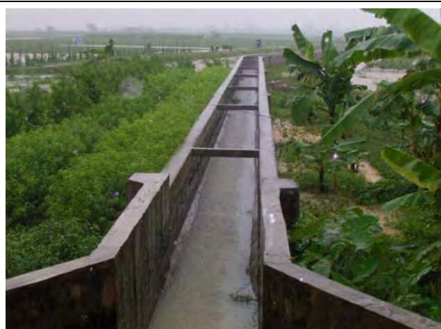
写真6：ハイズン省ジアロック県（ポンプ灌漑） ポンプ場吐口～基幹（一次）水路
