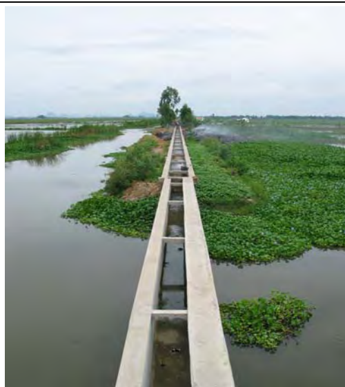
写真9：クアンニン省イェンフン県（重力灌漑） 二次水路
