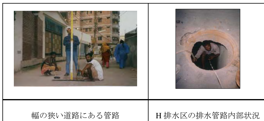
写真 3.7 H 排水区の雨水管の現状
