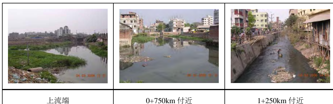
写真 3.4 セグンバギチャ水路の開水路区間の現状
