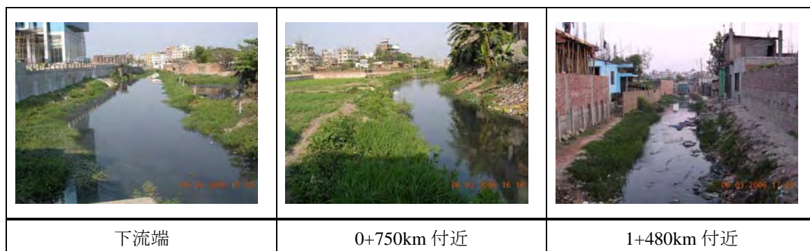
写真 3.6 ミルプール水路の開水路区間の現状
