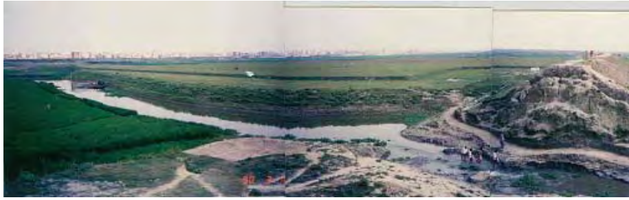
第一次工事開始直前の開発前のポンプ場南側堤内地状況（1990年）
