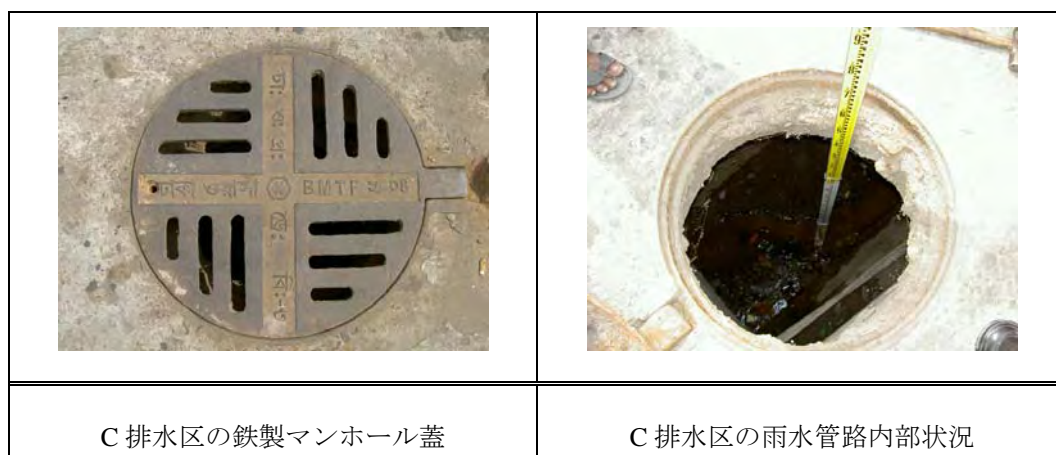
写真 3.5 C 排水区の雨水管の現状
