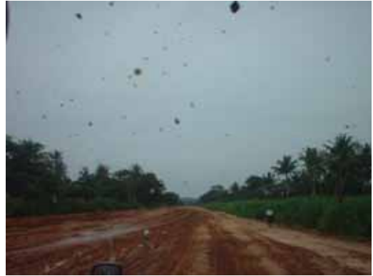
リンディ周辺の工事中区間(路盤工事中断)
