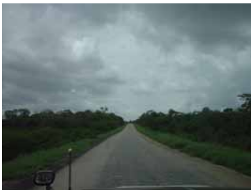
ミテジャの先の国内業者施工区間
