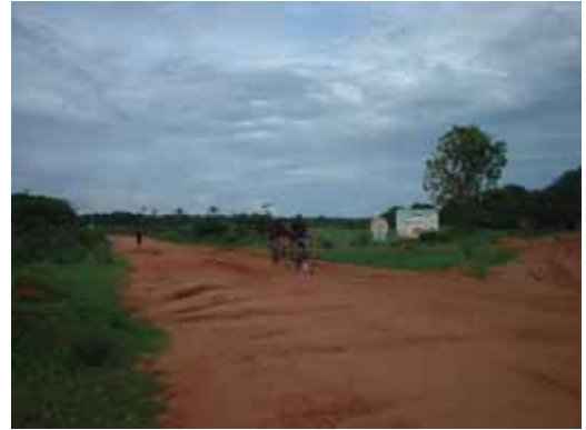
3km付近の路面状況
