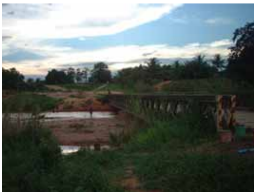
1990年に橋が流失したための迂回仮設橋
