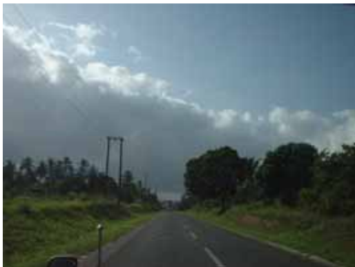
ダルエスサラームとブング間の舗装
