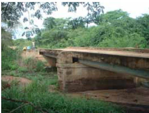
31km付近のコンボジット2径間橋梁
