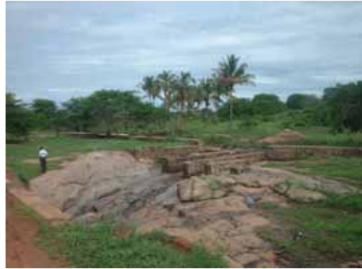
51km付近マンガッカの手前の防水堤
