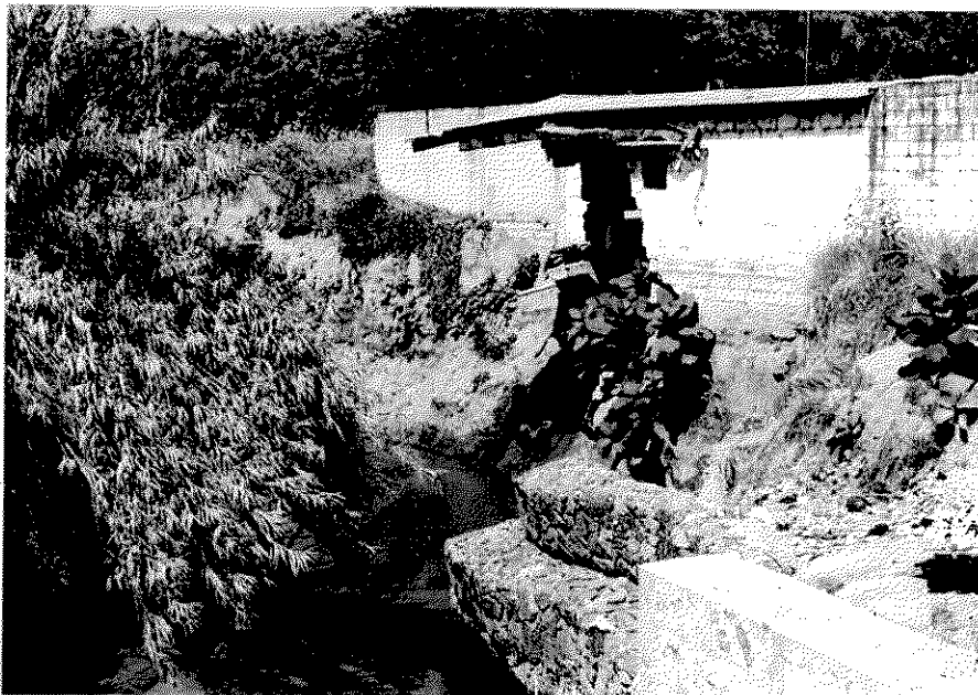
蛇行によって河岸が 著しく浸食され、住 宅が流失しかけてい る (Guatemala市南部 Villa Nuevo)
