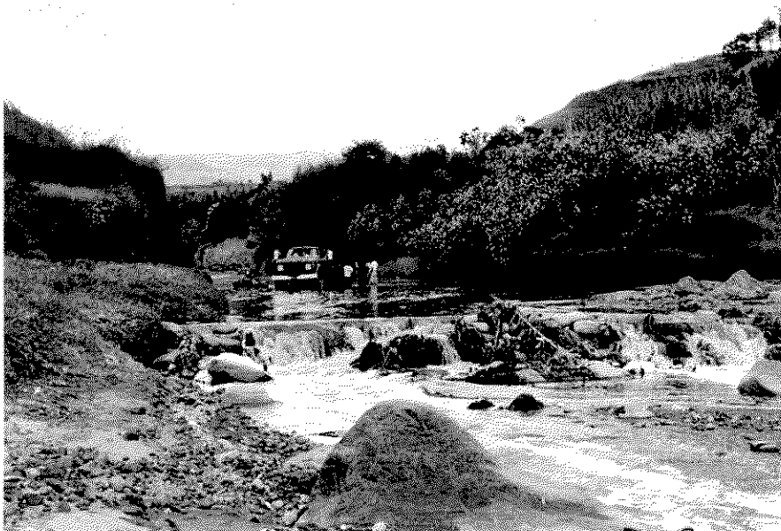
河川での土取り。河 床の低下に寄与して いる (Guatemala市南 部Rio Vallalobos)
