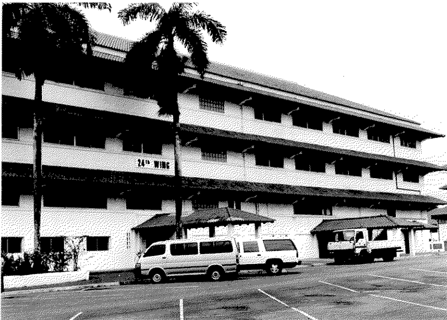
ハワード基地あとの建物（このような大きな建物が多数ある）
