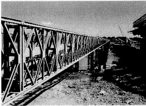
Lempa川を渡る仮橋。交通量が多いときには 渋滞を引き起こす。大型車両は通行できない。
