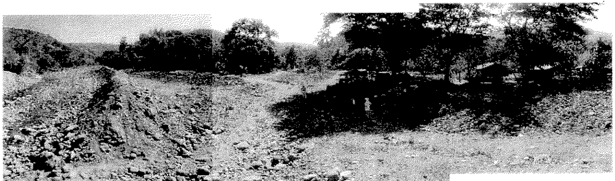
Chilangueraの土石流現場。このあたりにあった集落は壊滅的な被害を受けた。
