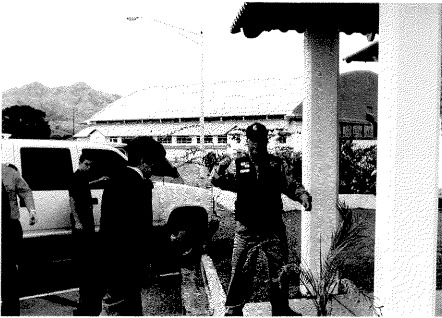
SINAPROCの局長の案内でハワード基地あとの建物を視察（SINAPROCやパナマ防災アカデミーがこの施設に入る予定である）
