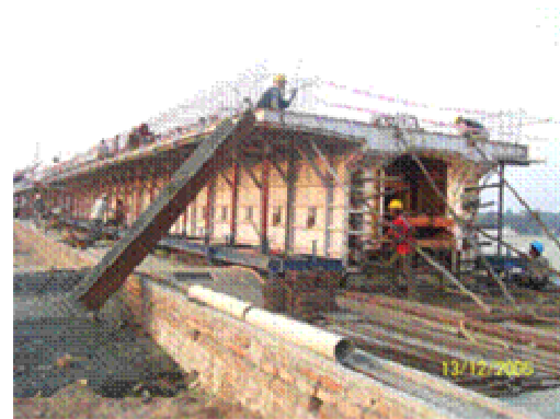
別添資料 図 7- 29 Box Girder Concreting
