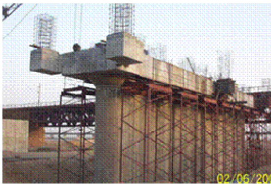
別添資料 図 7- 28 Pier Cap Deshuttering
