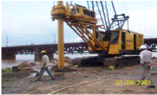
別添資料 図 7- 26 新橋の基礎打込(背後既存鉄橋) 別添資料 図 7- 27 新橋の基礎工事
