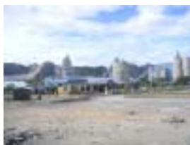
Cemen Bosowa Maros (cement)
