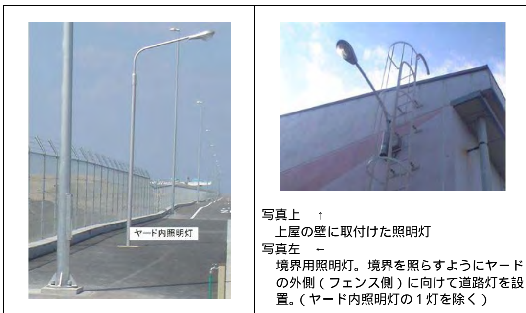
写真 15-4-2-1 境界用照明灯の設置状況
