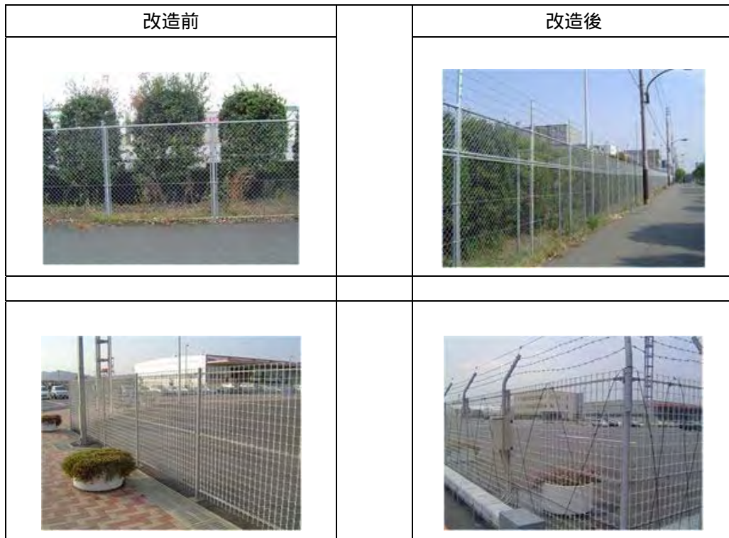
写真 15-3-1-2 フェンスの改造状況
