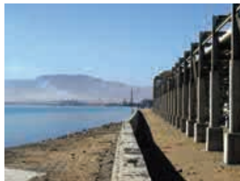
スエズ運河の汚濁の原因の1つとされている石油化学コンビナート工場群(奥)。プロジェクトではスエズ運河の流出油対策も実施している。
