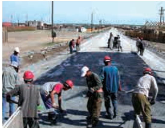
住民が参加して草の根技術協力で行われた生活道路の舗装(モンゴル、バガヌール地区生活環境整備)
