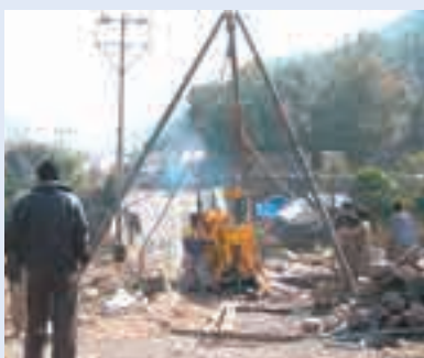
橋梁復旧に向けたボーリング調査
