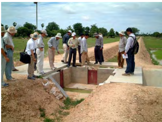
3次水路と排水路との交差部分の施設
