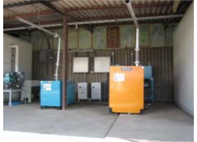
写真2)同コールドルームに設置されている自家発電装置(Phase1にて設置、左；冷蔵用、右；冷凍用)
