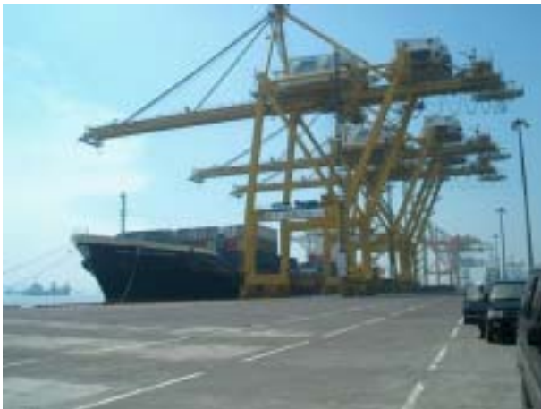
TPS (コンテナターミナル) ・昨年 1.1 百万 TEU ・外貿用 1000m 棧橋、クレーン 8 基、内貿用 450m 棧橋、クレーン 2 基
