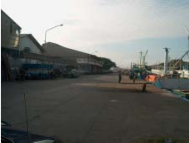
タンジュンペラク港内 (カリ・マス) ・河口港としての発祥の地 ・狭隘な河川に沿って、他島との運航に使用されている小型船が多数係留されている
