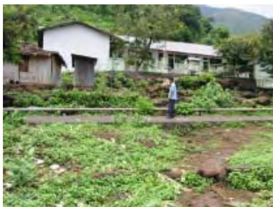
計画サイト前面山側の市水送水管。市水の引き込みはここから可能である
