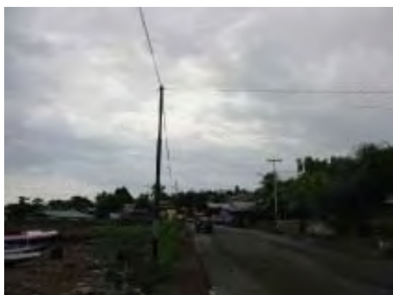
計画サイト前面道路沿いの架空電話線。電話の引き込みはここから可能である
