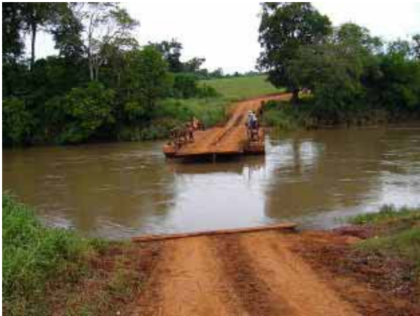
ナクンダイ川の浮き橋
