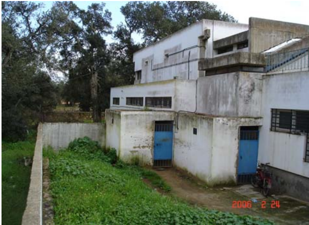
結核病棟を改修したため複雑な構成(本計画接続部分)
