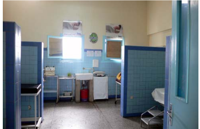
分娩室(6ブース)は狭く、換気が悪い
