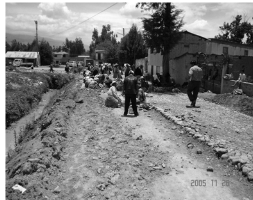
道路舗装工事状況
