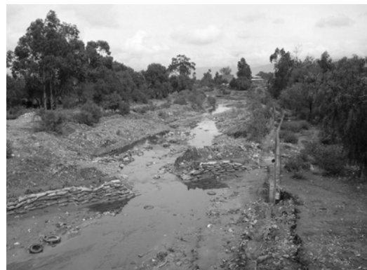
取水工（中央幹線水路）の現況
