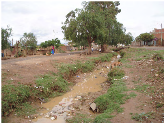
土水路区間の現況
