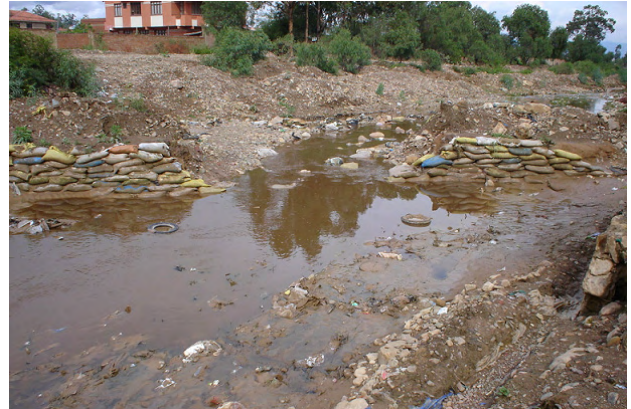
取水工（中央幹線水路）の現況
