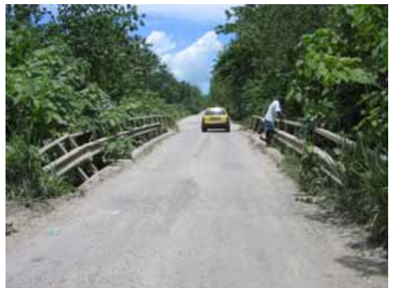
テナル2橋の現況 高欄に損傷を受けている
