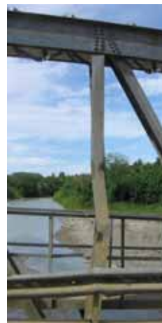
写真 3.5 衝突により損傷を受けた鉛直材
