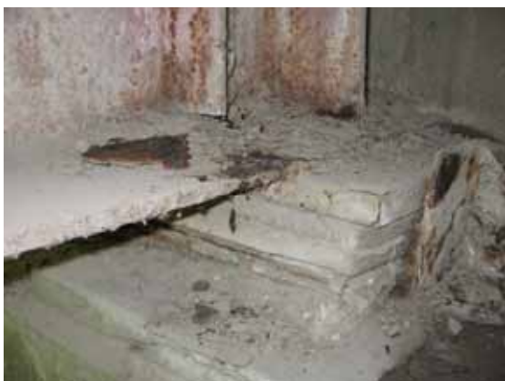
テナル2 橋の現況
