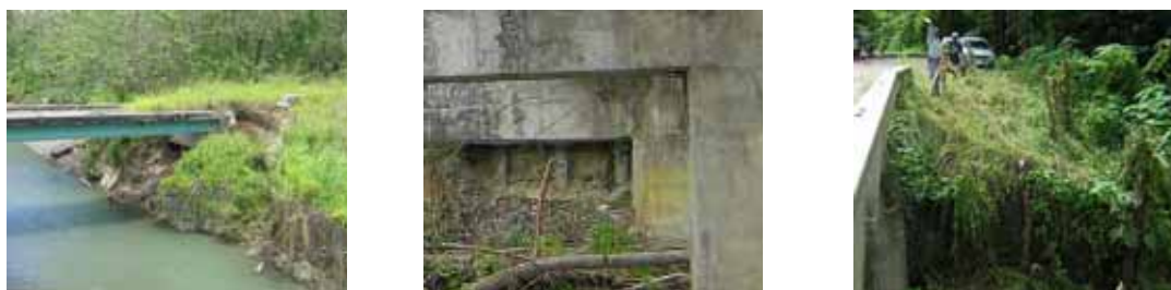
写真 3.8 ガリンビウ旧橋橋台(1) 写真 3.9 ガリンビウ旧橋橋台(2) 写真 3.10 テナル 1 既存橋
