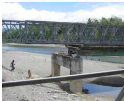
写真 3.2 2 径間を流失した旧橋
