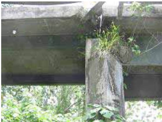
テナル1橋の現況 橋脚上の床版張り出し部が欠落している
