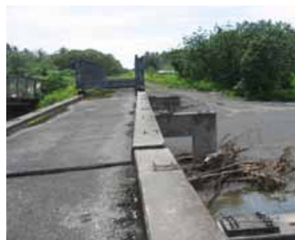
写真 3.3 「く」の字に曲がった上部工
