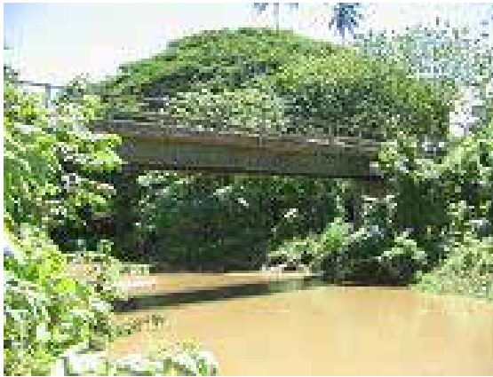
テナル1橋の現況 東側下流より望む
