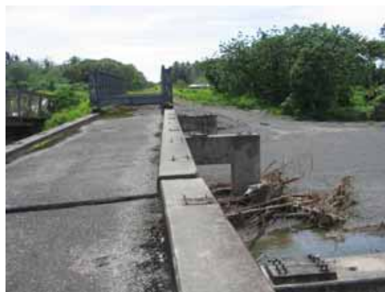
ガリンビウ旧橋の現況
