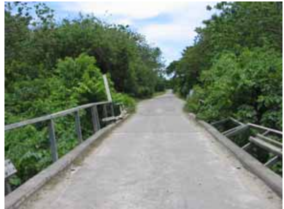
テナル1橋の現況 高欄に損傷を受けている
