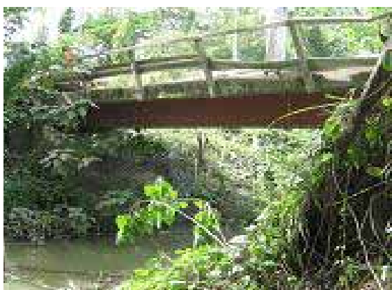
テナル2橋の現況 西側下流より望む
