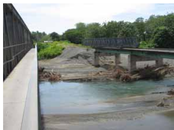
ガリンビウ旧橋の現況
