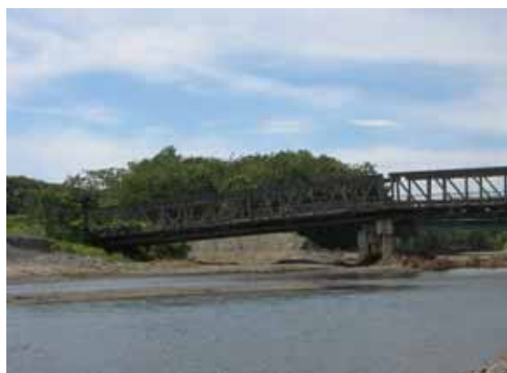
ガリンビウ現橋の現況
