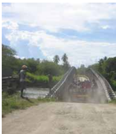
写真 3.4 現橋を通行するトラック
