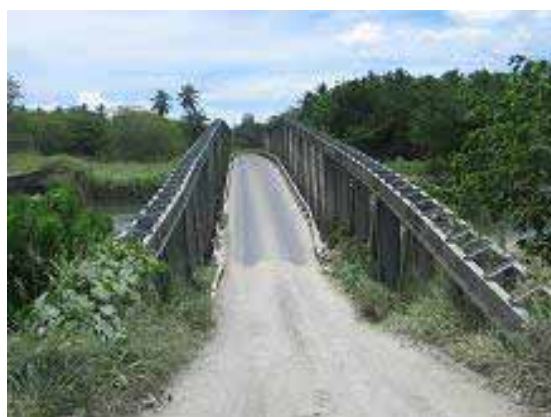
ガリンビウ現橋の現況
