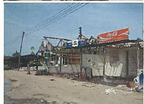
上：沿道の移動可能なキオスク 下：すでに所有者により撤去が進む、サムニュジョマ道路用地内の簡素な作りの商店
