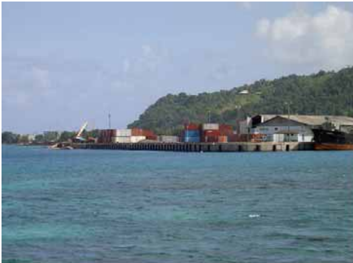
写真 - 1 ウエノ港 B 岸壁全景。
