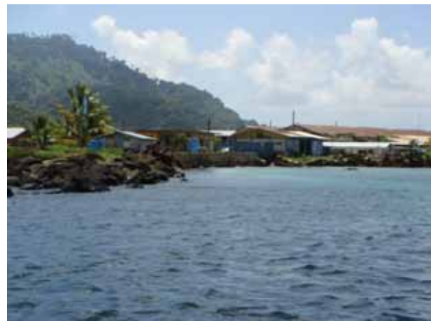
(防波堤：港外側)
