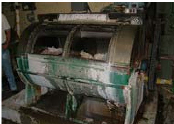
ランドリー: 1940年代の洗濯機が稼動中であるが、スペアパーツはなく、類似部品を加工して対処している。
