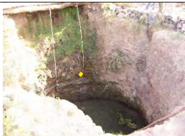
写真-2：既存の手堀り井戸（デバルワ市）。水質上安全でない水に依存している。
