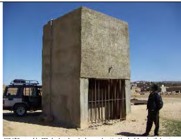
写真-6 使用されなくなった公共水栓（デケムハレ市）配水管の破損により、現在は使用されていない。
