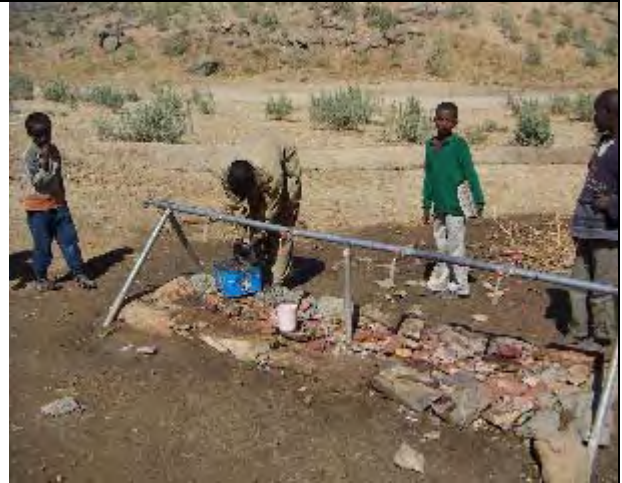
写真-8 赤十字により設置された応急給水施設（マイディマ市）施設容量が不足しており需要を満たしていない。
