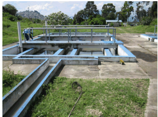
写真2 EMPAGUA によって運転されている 1982 年に建設されたベジョス・ホリゾンテス下水処理場。
