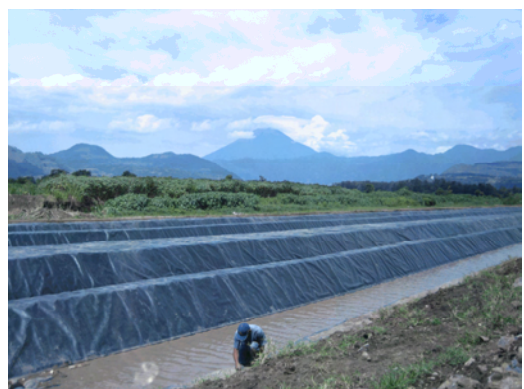
写真6 ビジャロボス川のアマティラン湖流入地点には AMSA による河川水処理施設（河川流量の約 30% 処理）が建設工事中。
