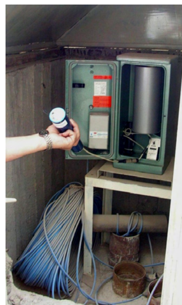
写真 5-7 Harasta 総局構内地下水観測所の井戸水位計設置状況
