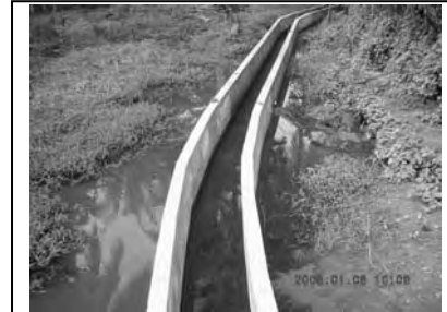
アヌラダプラ水道計画で改修された左岸幹線水路 (トウルウィラ灌漑地区)
