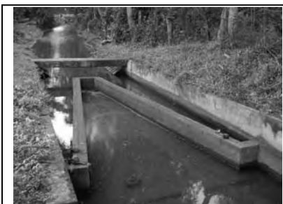
ダックビル堰は長い堰長を持ち流量変化に対して水深の変化を小さくしている。 (ラジャンガナ大規模灌漑地区、トラクト 2 地区 D-水路)
