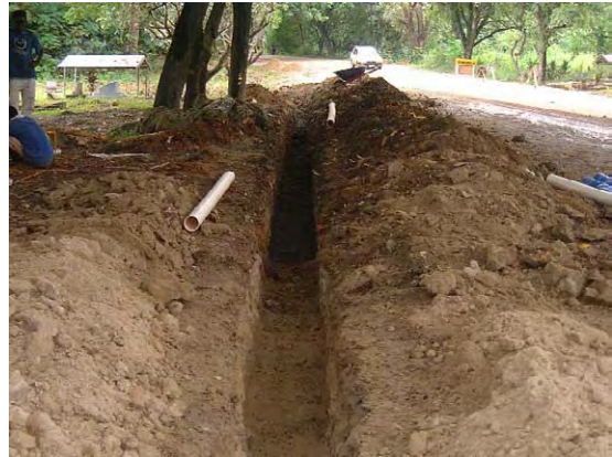
Kola Ridge 地区での管路敷設替え工事のようす。
