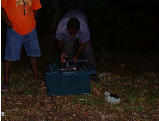
漏水削減指標の確立のためのパイロット・プロジェクト。漏水調査を実施し、12箇所を選定した。この写真は、12箇所の1つである、Vavaya Ridge 地区の配水管路。敷設替え前の漏水量（夜間最小流量）測定を行っているところ。
