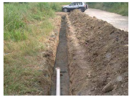
Kukum Campus 地区での管路敷設替え工事のようす。
