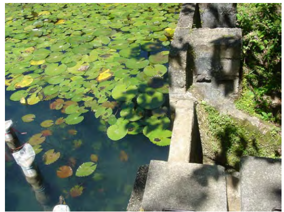
ロベ湧水の取水地点及び堰のようす。水草が浮いているが、水質に問題はない。
