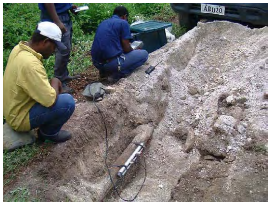
Kukum Campus 地区での敷設替え前の漏水量測定の様す。
