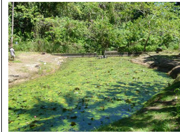
ロベ湧水。ホニアラ市内に3箇所ある湧水の一つ。同湧水からの取水量は、コングライ湧水の7分の1と小さい。主に、Point Cruz地区に配水されている。
