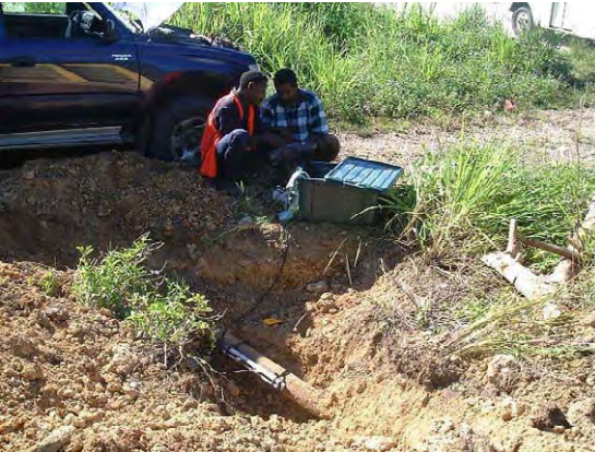
Kola Ridge 地区での敷設替え前の漏水量測定の様す。
