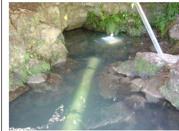
コングライ湧水の取水地点。同湧水は、現在、ホニアラ市の配水量の50%を賄っている。しかし、2005年10月に発生した水源での閉塞事故により、同配水量は40%まで減少している。
