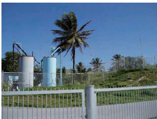
ろ過装置（浄水場 A） 青色（右）が 98 年更新されたろ過装置
