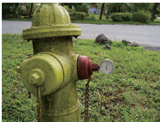
配水管末端水圧（Rita 地区） 心配された末端における水圧に問題はなかった（1.5bar）
