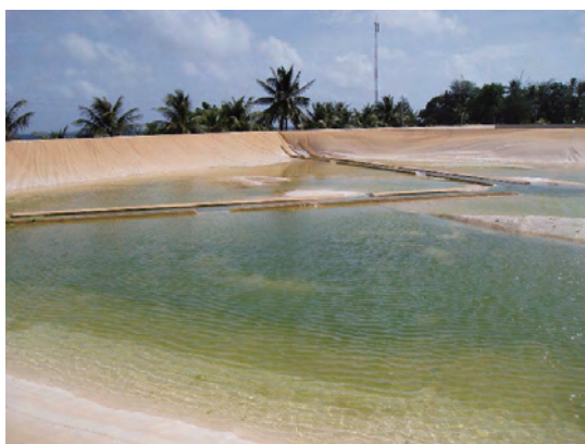
処理水貯水池（浄水場 C） ろ過処理をした水の貯水池。蒸発防止用のシートがかかり、その上に雨水がある状態
