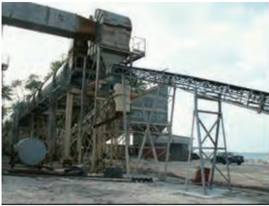
ロジェムワ地区のアスファルトプラント
