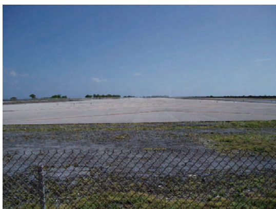
マジュロ空港滑走路 滑走路の雨水を収集している
