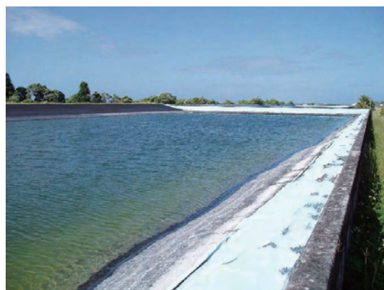
原水貯水池（浄水場 C） 容量 500 万ガロン（約 150×65m）の原水用貯水池
