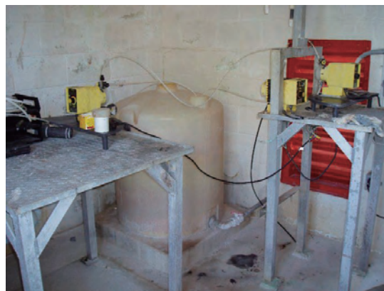
塩素注入装置（浄水場 A） 1998 年に更新された塩素注入装置
