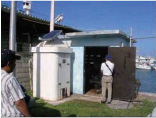
ウリガ海水ポンプ場 トイレの水洗用に使用する水を供給している
