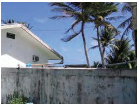
一般家庭の雨水集水装置
