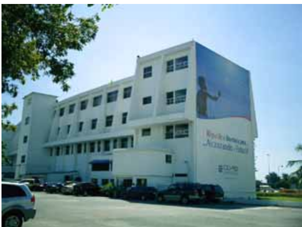
写真- 3 : 既存建物の裏側外観。建設予定地は、建物に続く右側および手前側である。
