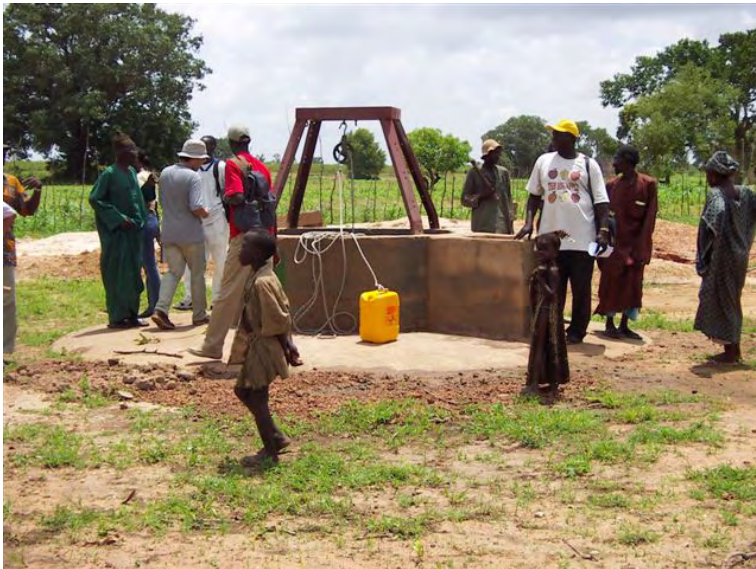
フィルギ地区 フィルギ・ガワン村新規掘削井戸
