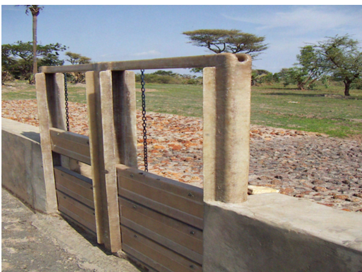
フィルギ地区 ヤエン村の防潮堤
