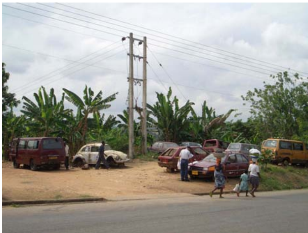
既設配電線との接続点
